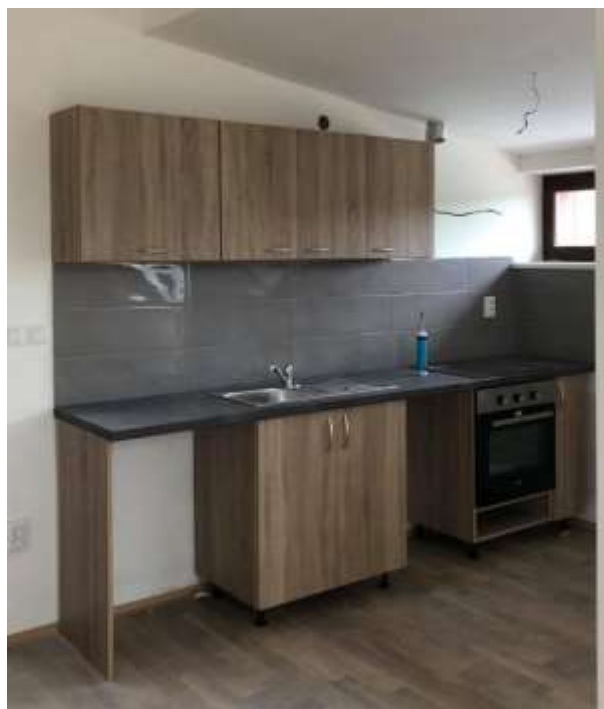
Rekonstrukce interiéru Azylového domu
